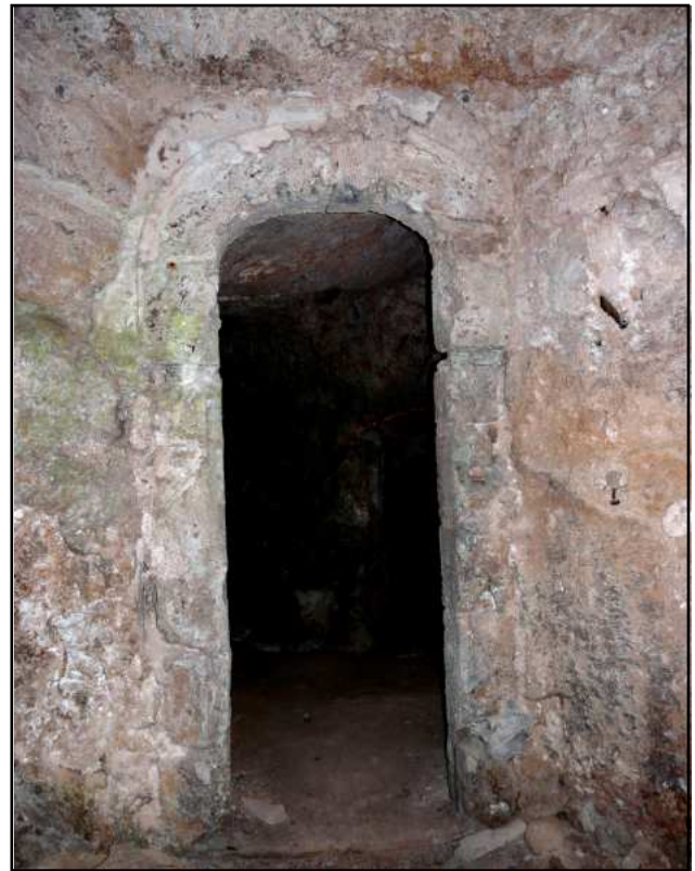
Fig. 4 : les appareillages de portes ou de voûtes que l'on trouve dans la grotte. Ici, la porte séparant le vestibule du couloir
