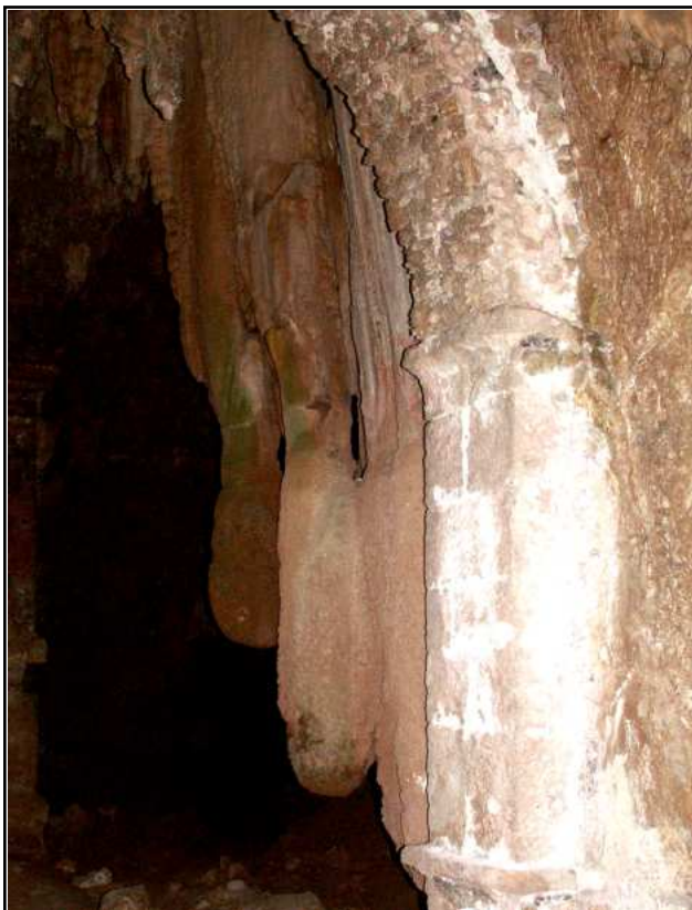
Fig. 7 : La séparation de la nef et du chœur, en belles pierres de taille. Les concrétions sont respectées.
