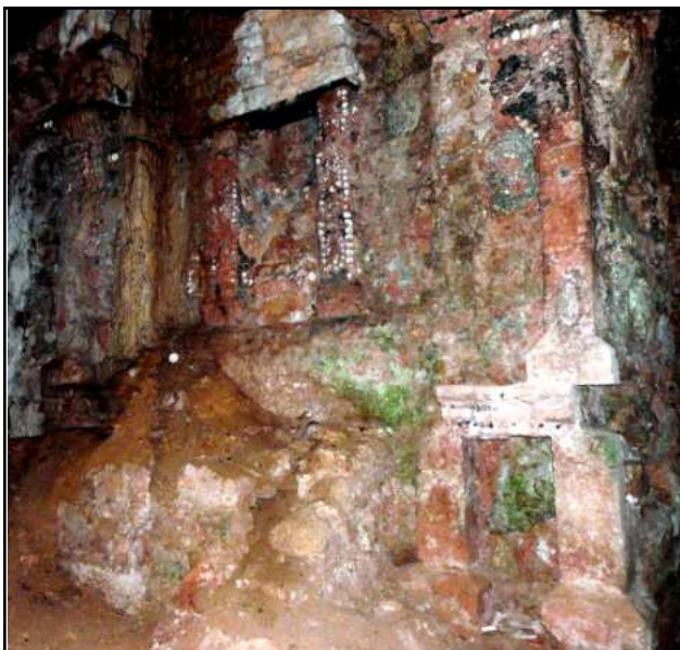
Fig. 8 : L'ensemble monumental qui surmonte l'autel est en meilleur état que ce dernier.
